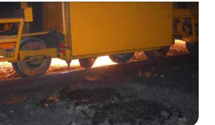
La imagen siguiente representa un ejemplo de la configuración de la unidad de amolado y de la modalidad de trabajo de cada módulo para recuperar el perfil transversal y longitudinal del carril.
